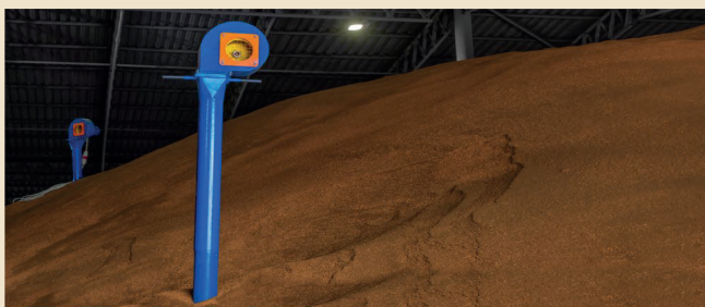
La ventilation est la clé du maintien de conditions de stockage optimales.
